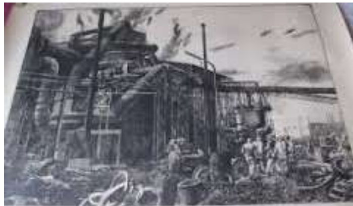
Görög Rezső: A szolnoki vegyiművek építése
