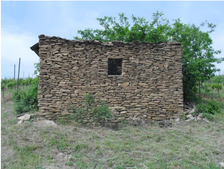
A szőlőművelők Mész hegyi pihenő kunyhója, lapos kövekből építve
