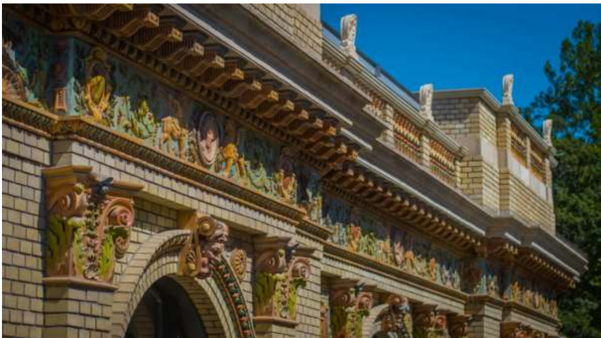
A felújított Olof Palme Ház, Budapest, Városliget
